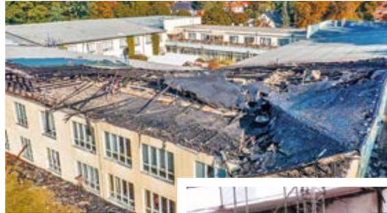
Der Brand zerstörte den halben Dachstuhl und beschädigte die Leitungen darin.
