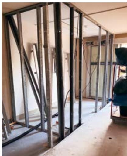
**Oben:** Neue Trockenbauwände geben dem Innenausbau wieder Struktur.
